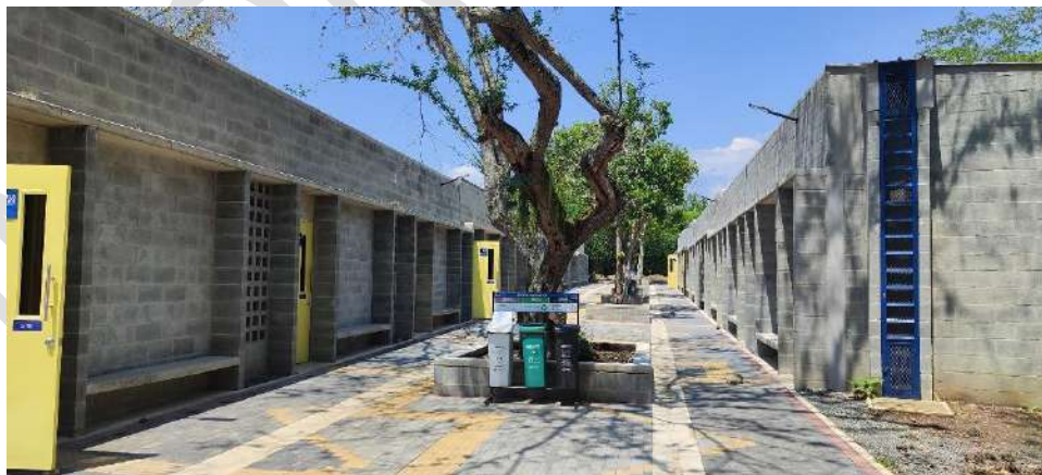
Vista General Bloque Alameda Sede Sur
