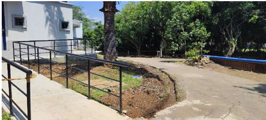
Acceso para Personas con Movilidad Reducida Baterías Sanitarias Biblioteca Jairo Panesso Tascón Sede Sur
